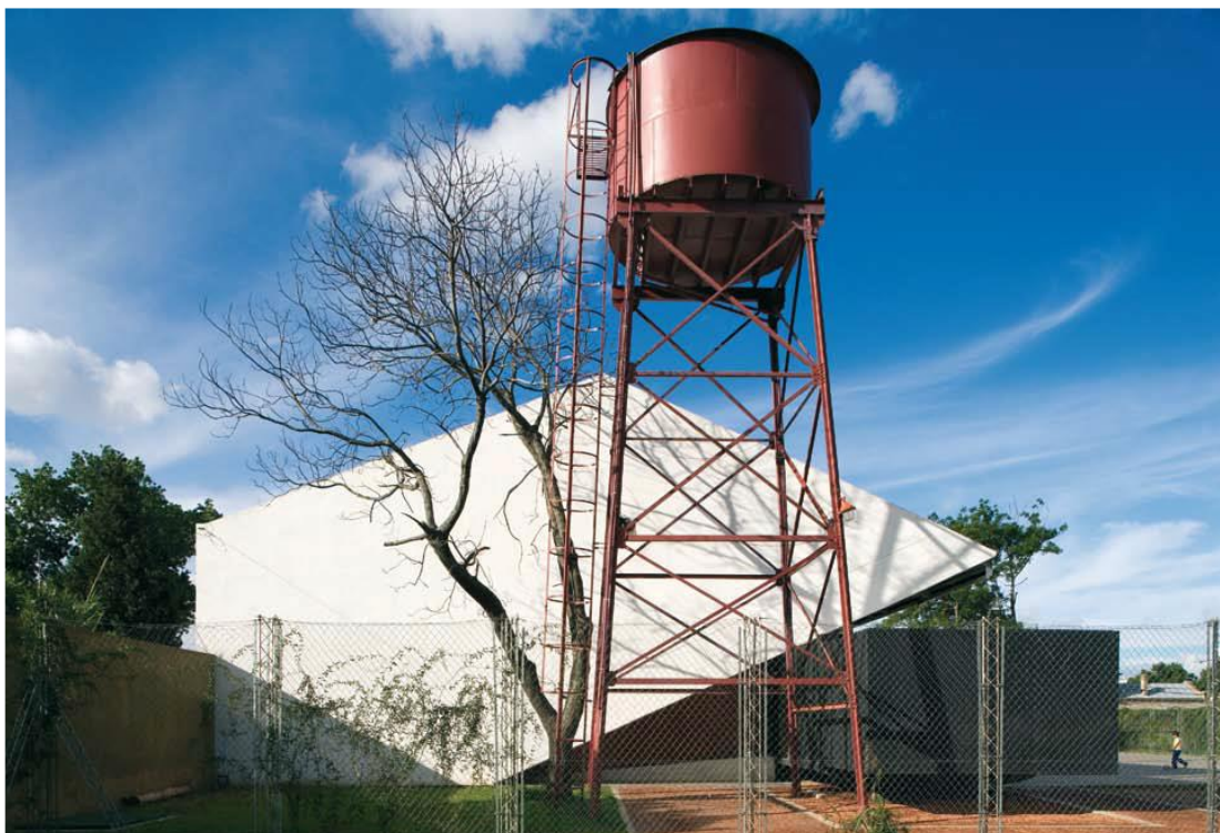
Ilustración 36 Fotografía de la obra publicada por sus autores.
